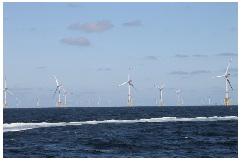
Foto: Offshore-Windpark Meerwind Süd | Ost
